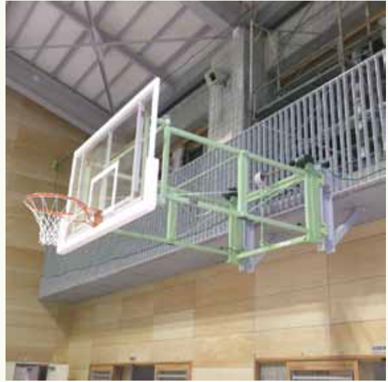
専用の架台：鉄骨の場合
