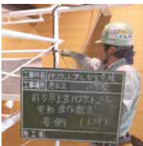
安全点検状況 点検の際はボルトの増締め等を行います。
