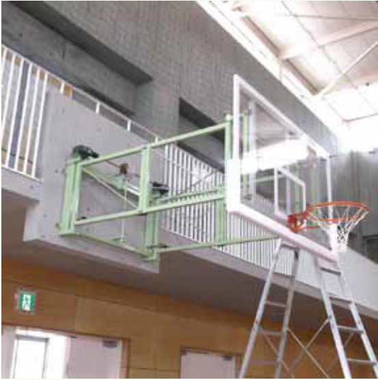
専用の架台：コンクリートの場合
